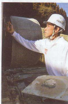
◎材料の乾き具合を見て仕上げるタイミングを計ります
